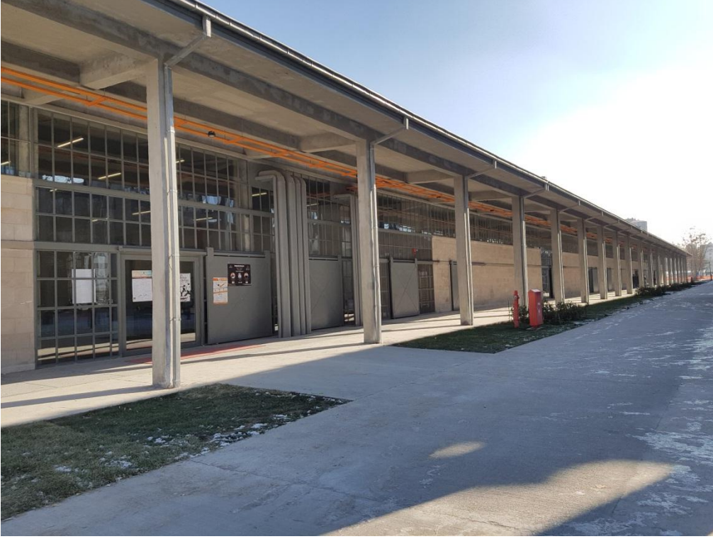
Resim 4: Büyük Ambar Binası dış mekan
