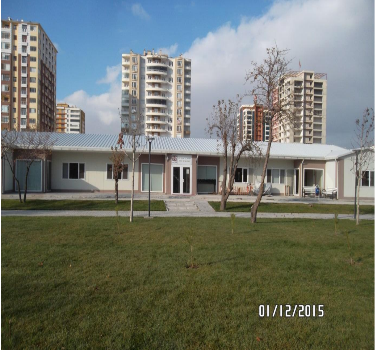
Yapı İşleri ve Teknik Daire Başkanlığı Hizmet Binası
